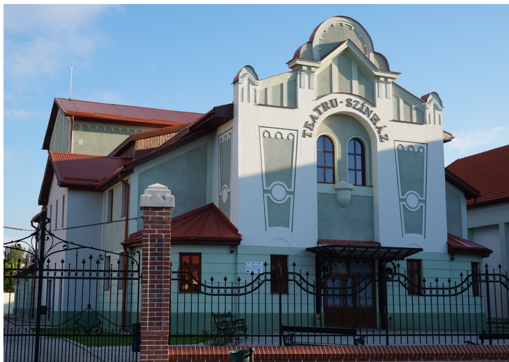
5. kép: A Városi színház felújított homlokzata, 2017 (a szerző felvétele)
