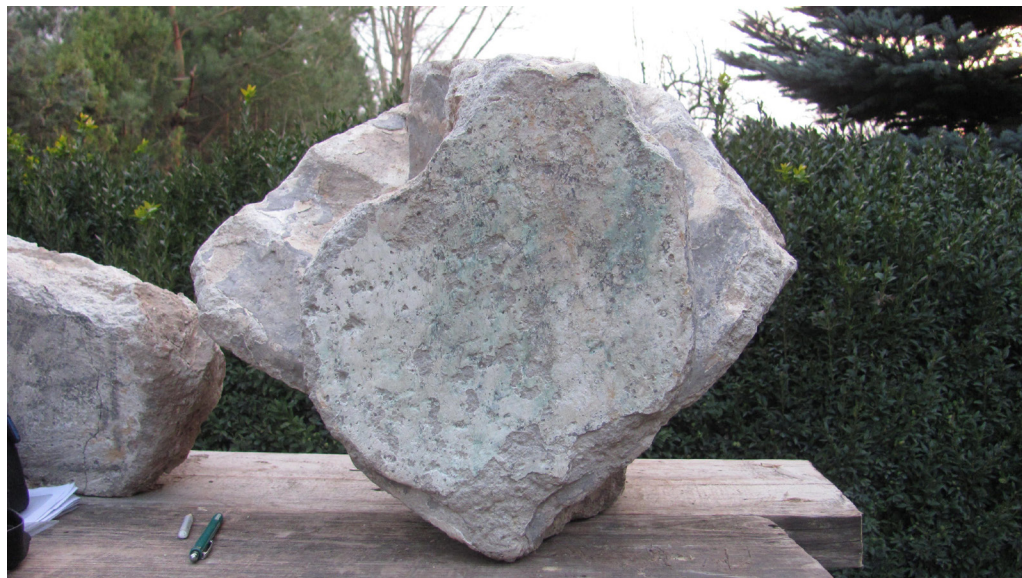
2. kép: Bordacsomópont a debreceni Szent András-templom (református Nagytemplom) északi kápolnájának egykori hálóboltozatából (a szerző felvétele)
